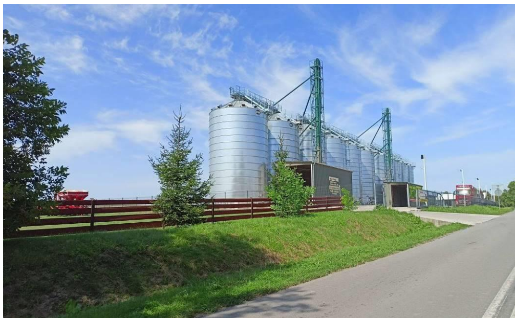
Fot. 5 Silosy na zboże w granicach opracowania
