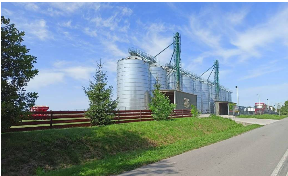
Fot. 5. Silosy na zboże w granicach opracowania
